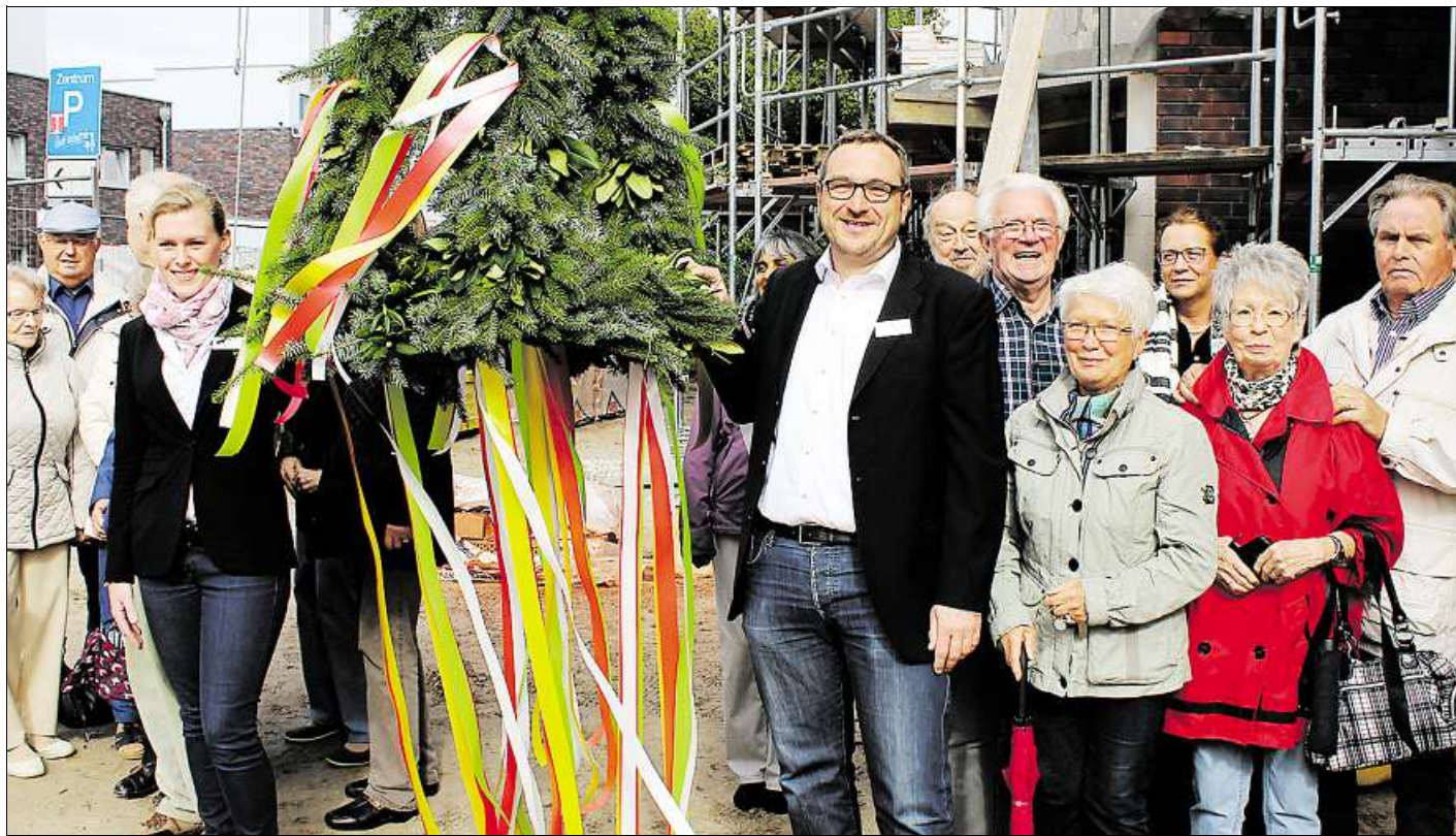
Gemeinsam mit einigen Gästen feierten die Geschäftsführer Lutz Mosel und Johanna Kaller Richtfest der Seniorenwohnanlage an der Straße Am Rechter in Westerstede. BILD: DESIRÉE SENFT
